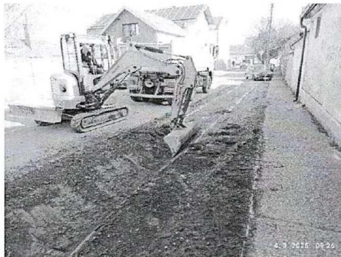
Радови на ископу земљаног канала у улици Младена Стојановића
