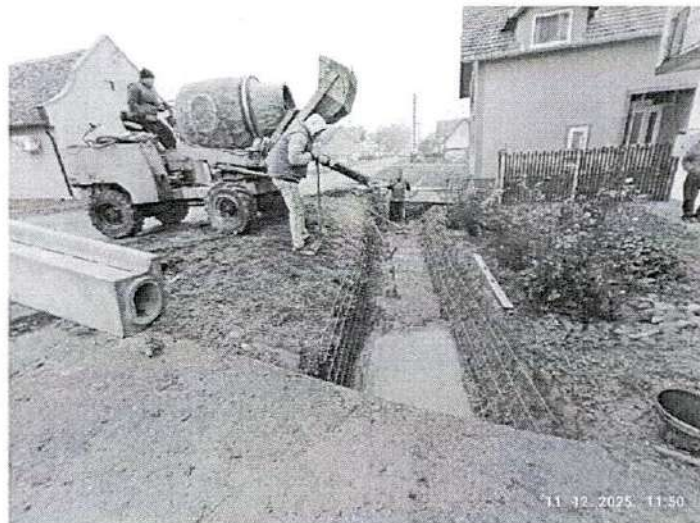
Радови на санацији објекта атмосферске канализације у улици Девет Југовића
