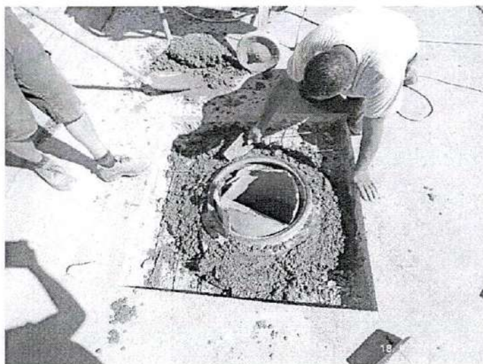
Радови на санацији објекта атмосферске канализације у улици Светог Саве
