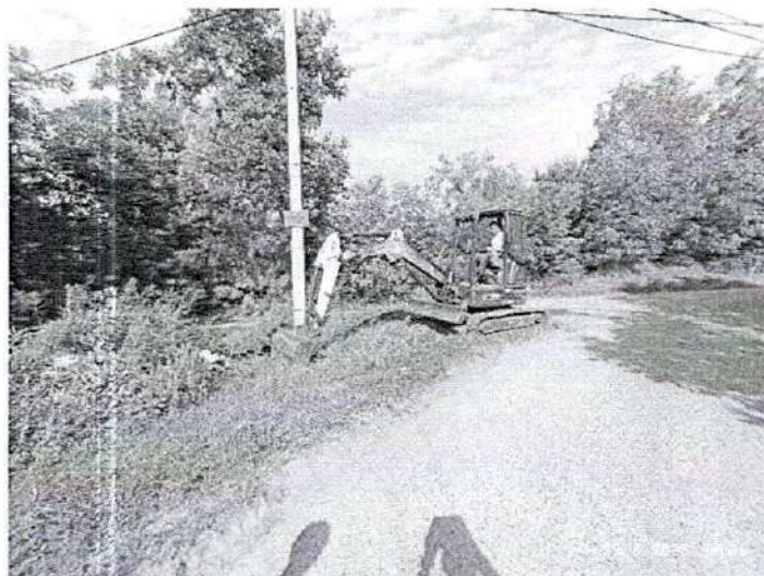
Радови на чишћењу банкина и профилисању канала у улици Јураја Витеза
