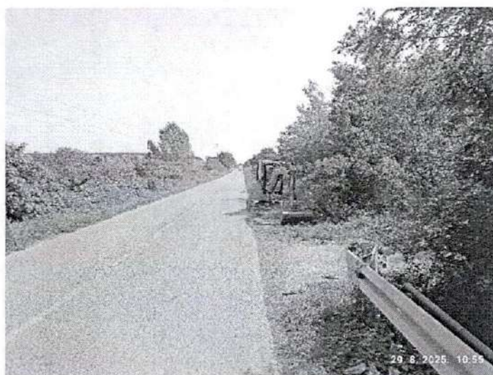
Радови на чишћењу банкина на делу општинског пута Нови Сланкамен - Крчедин
