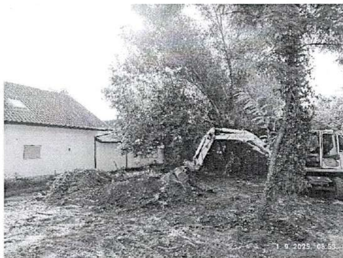
Радови на чишћењу платоа и профилисању земљаних канала у улици Авалској
